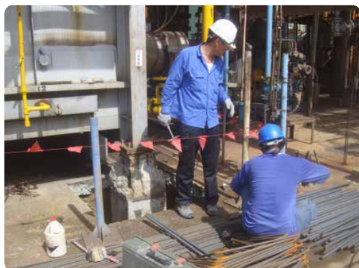
▲ 爐體基礎製作
